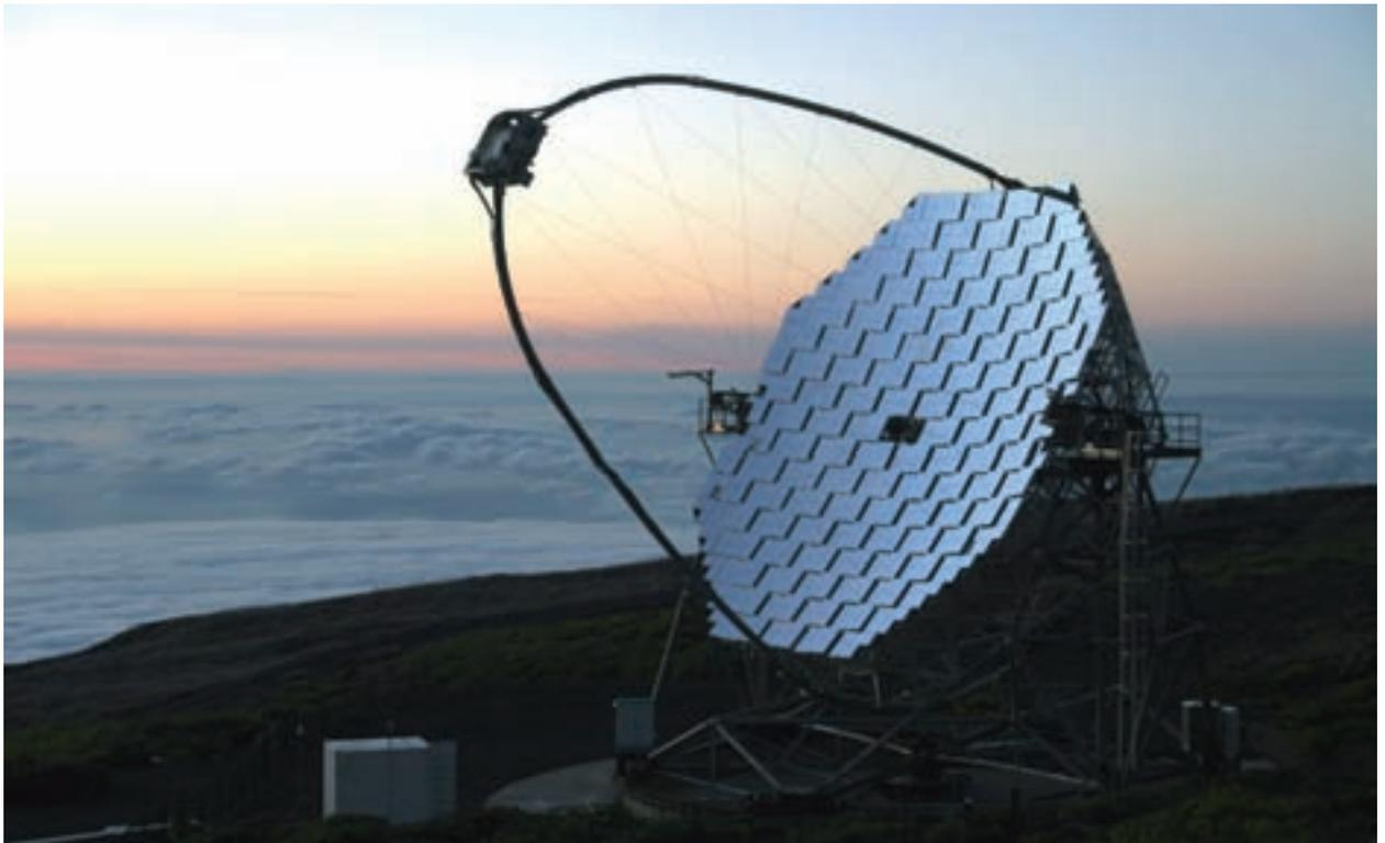
Das MAGIC-Teleskop auf La Palma ist das größte Luft-Tscherenkow-Teleskop. Ein leichtes und stabiles Gerüst aus Kohlefaser trägt den Detektor, dessen aktive Spiegeloberfläche 234 Quadratmeter groß ist, bestehend aus 900 einzelnen „Augen“. Eines der herausragenden Merkmale von MAGIC ist die kurze Reaktionszeit, mit der das Teleskop auf jeden Punkt am Himmel ausgerichtet werden kann.
