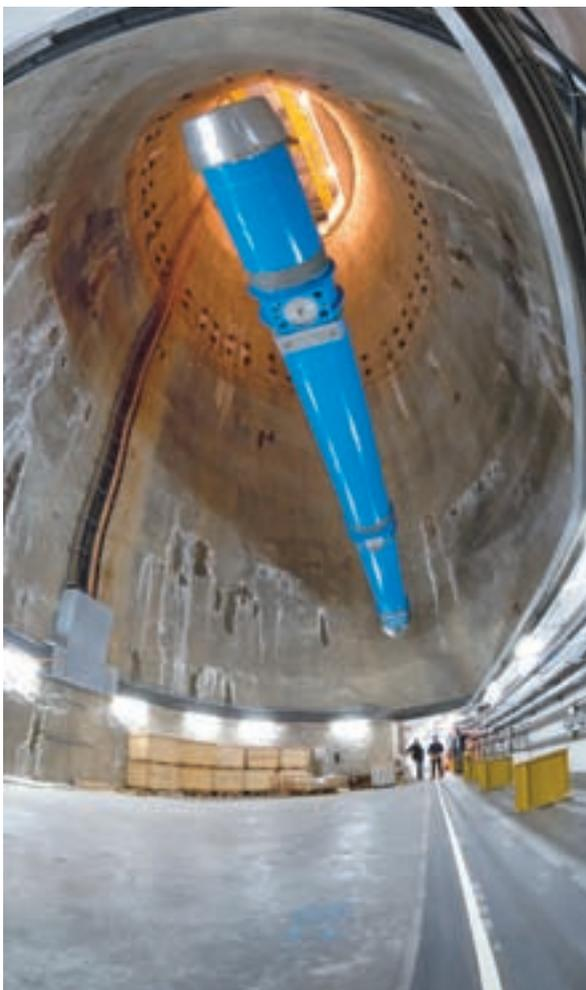
Durch einen Spezialschacht wird der letzte der 1746 supraleitenden Magneten in den Tunnel des LHC hinabgelassen. Er ist einer der 1232 Dipolmagneten, mit denen die Teilchenstrahlen auf ihre 27 km lange Kreisbahn gezwungen werden.
