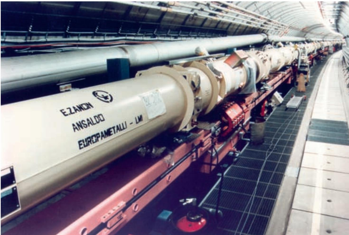
Der Blick in den 6,3 km langen Tunnel des HERA-Beschleunigers zeigt oben die supraleitenden Magnete zur Führung der Protonen und darunter den Elektronenring. Was passierte, wenn die Protonen und Elektronen mit hoher Energie zusammenstießen, beobachteten empfindliche Detektoren. Die Auswertung ihrer Daten wird noch einige Zeit in Anspruch nehmen.
