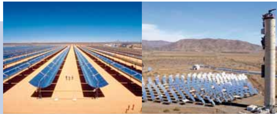
☞ Varianten der Solarthermie: Bei Turm-Anlagen (1. Bild links) wird die Sonnenstrahlung von Spiegeln auf einen Turm gerichtet, bei Kraftwerken mit Parabolrinnen-Kollektoren (2. Bild links) auf ein Rohr fokussiert, das oberhalb der Kollektoren verläuft. In beiden Fällen wird letztendlich Dampf erzeugt. Bilder: DLR
