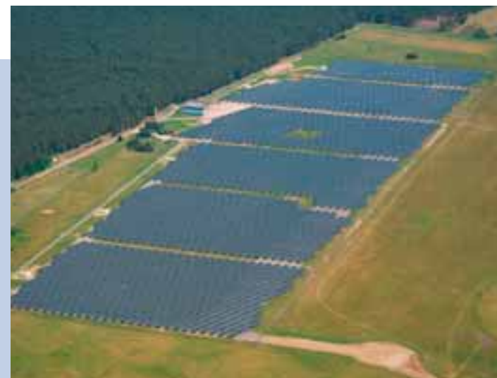
↑ Bei Leipzig steht der zurzeit weltweit größte Solarpark mit Dünnschicht-Solarzellen. Die Anlage „Rote Jahne“ leistet 6 Megawatt und ist so groß wie elf Fußballfelder. Bild: Juwi
